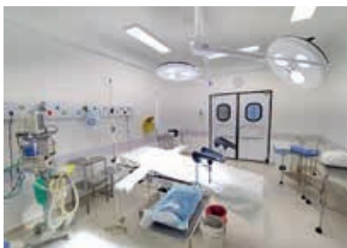
Reforma da sala de cesária
