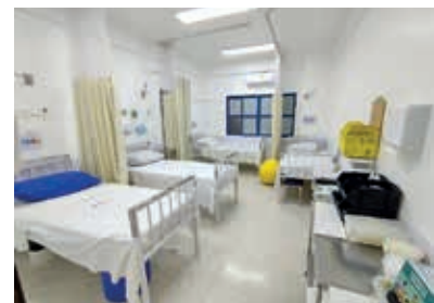
Reforma da sala de pré parto
